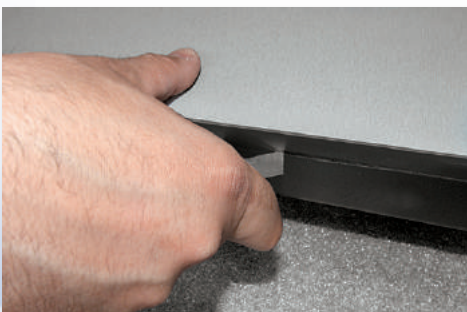
Bei einem Fertigboden ist es vorteilhaft, den Rand innerhalb der Einbau-Box nochmals um ca. 5 mm zurückzuschneiden, damit am Ende eine saubere Kittfuge gemacht werden kann.
