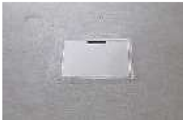
Bild 4: Bodendose mit gegossenem Bodenbelag Image 4: Boîte de sol avec revêtement de sol coulé
